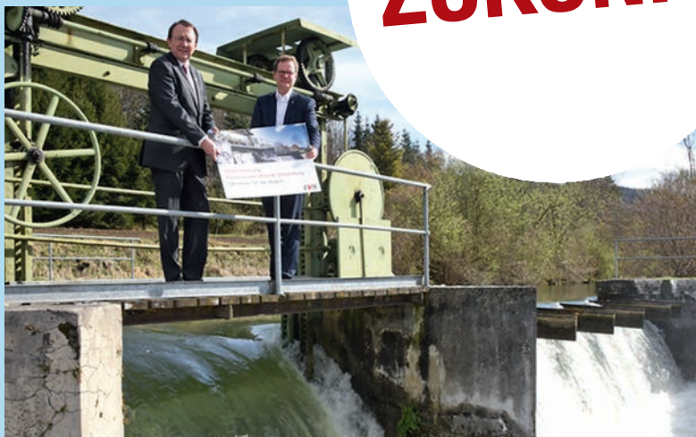
Bürgermeister Matthias Stadler und EVN-Vorstand Stefan Szyszkowitz begutachteten das über 100 Jahre alte Kraftwerk im St. Pöltner Stadtteil Ochsenburg.
