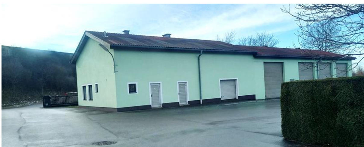
Abbildung 32: Wohn- und Bürogebäude (Abb. oben) und Garagen-/Werkstättentrakt (Abb. unten).
