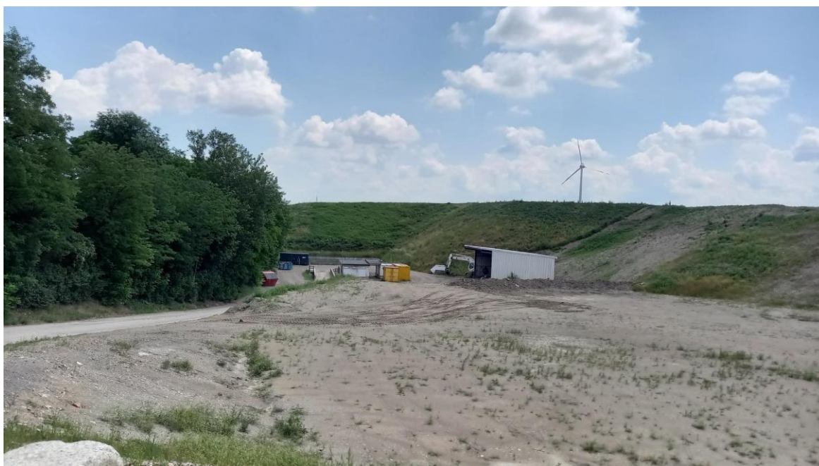
Abbildung 7: Gebäude am nördlichen Bereich des Projektareals
