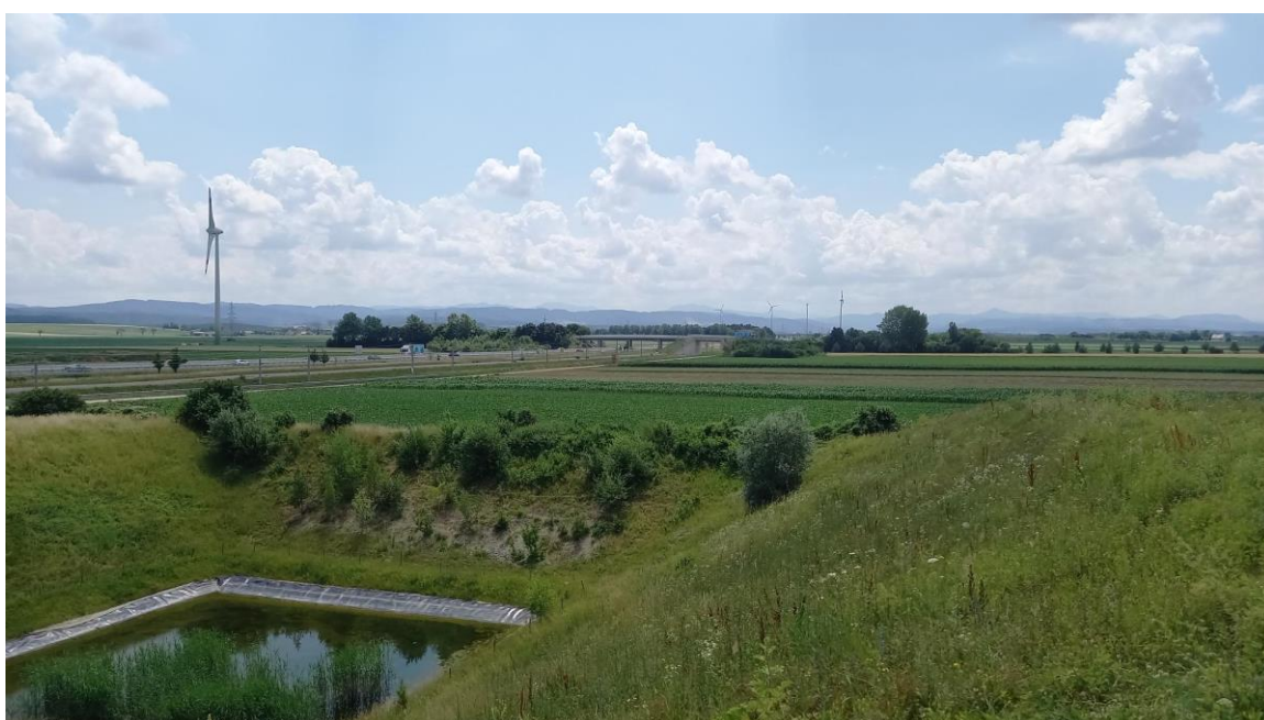
Abbildung 8: Retentionsbecken im Abböschungsberiech knapp außerhalb des umzuwidmenden Areals
