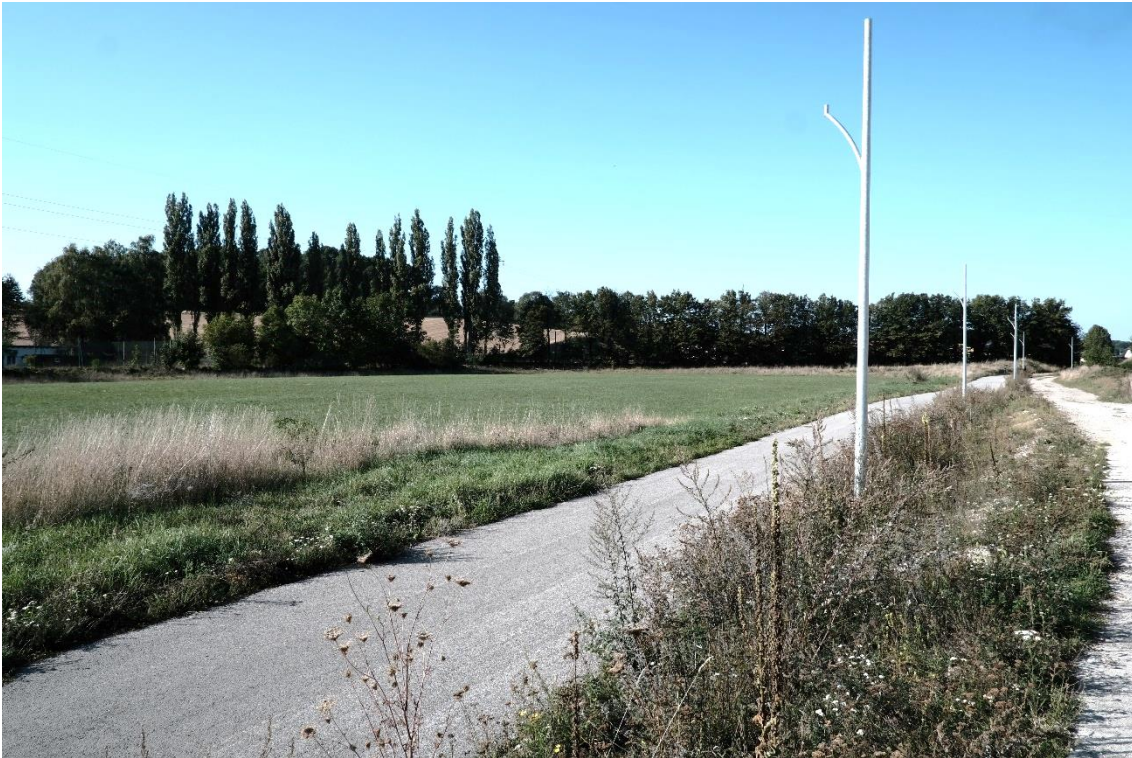
Abbildung 13: neuer Geh- und Radweg – Foto m. Blickrichtung Norden, Quelle: eigene Aufnahme
