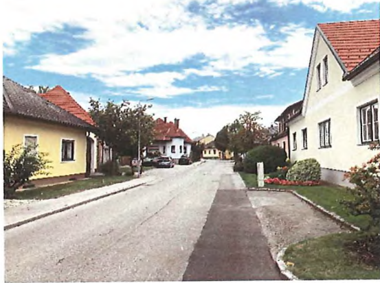
Buchbergerstraße, mit überformten Bauernhäusern
