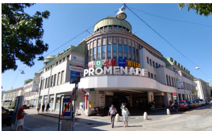
Einkaufszentrum Promenade Bräuhausgasse/Brunngasse
